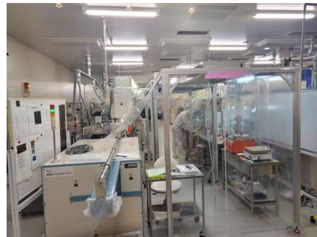
クリーンルーム
